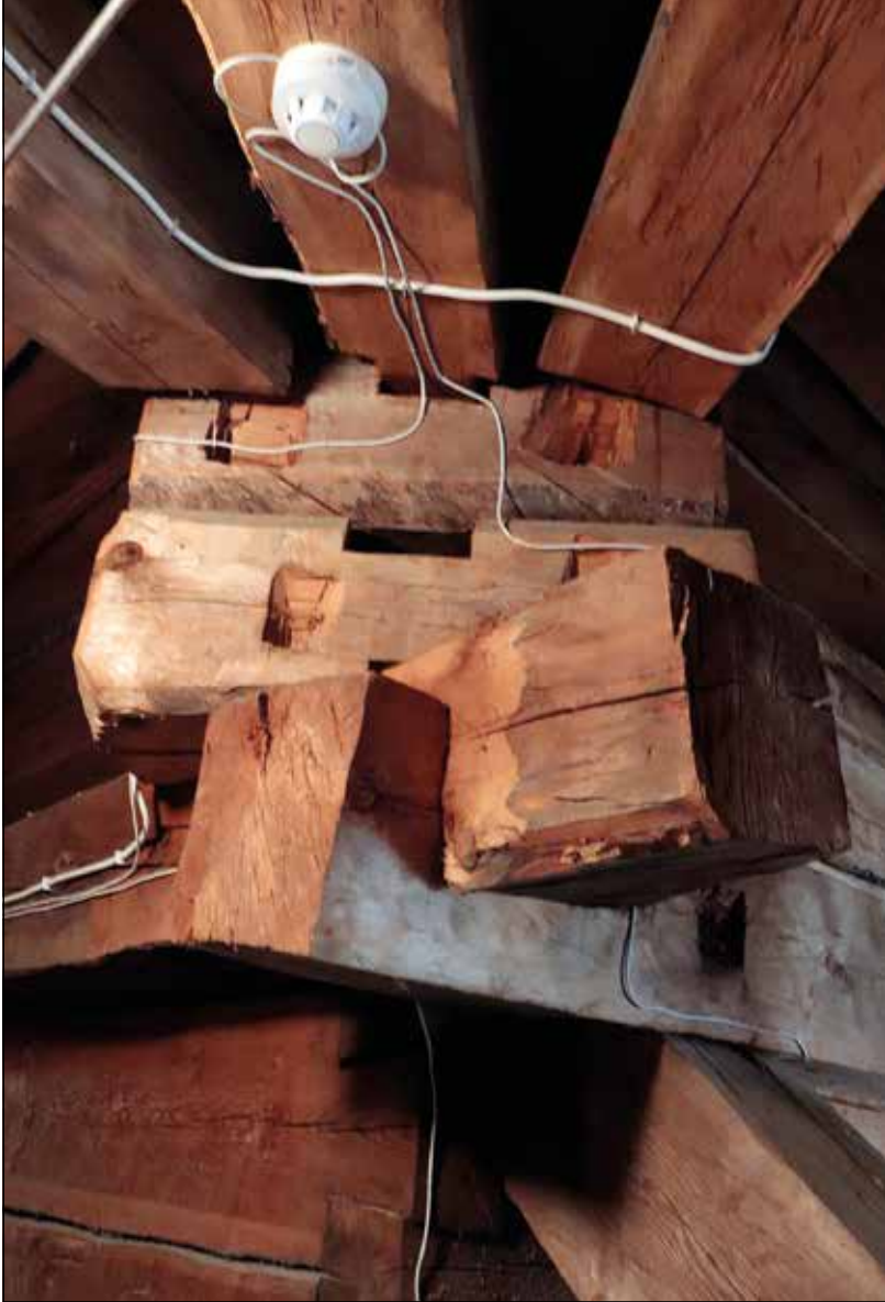
Kuvassa 1840-luvulla rakennetun Rautalammin kirkon ullakon vesikatkon kannattajien tuenta salvoksin. Nyky aikaista on palovaroituslaitteiden mukana olo.
