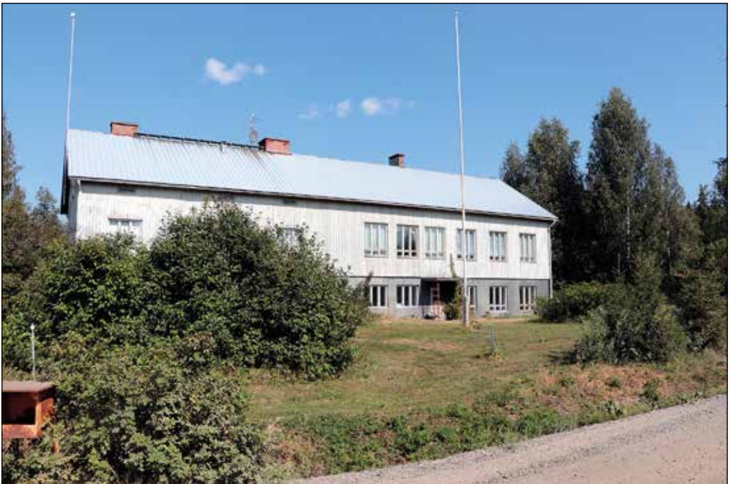
Pukkiharjun koulu kuvattuna ”tiensä” päässä.
